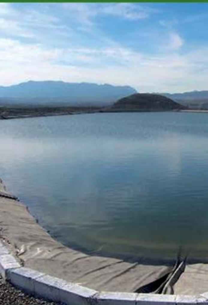
La géomembrane de **DIMATIT** est un film homogène obtenu par extrusion gonflage en tri couche.
